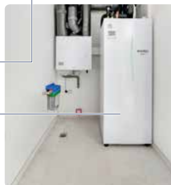
Ecodan Cylinder, vodna enota toplotne črpalke z integriranim rezervoarjem sanitarne vode.
